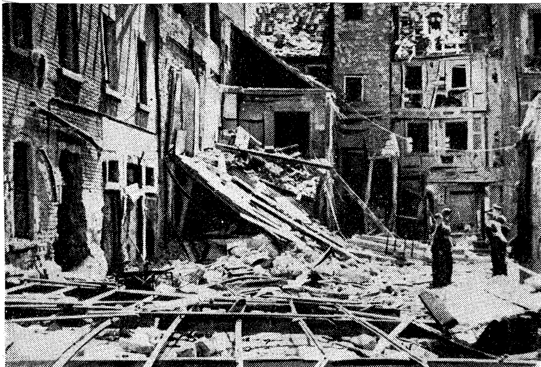
Voici dans une ville allemande les dégâts causés par une bombe anglaise
