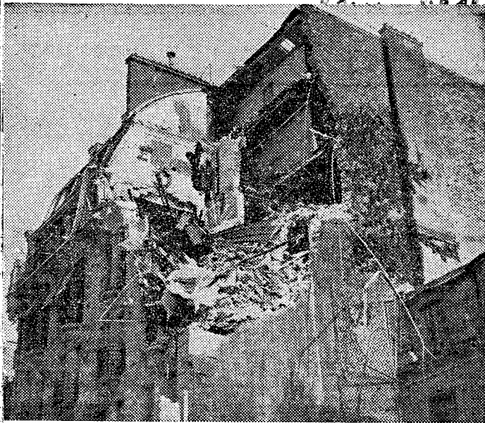
UN IMMEUBLE PARISIEN ATTEINT
